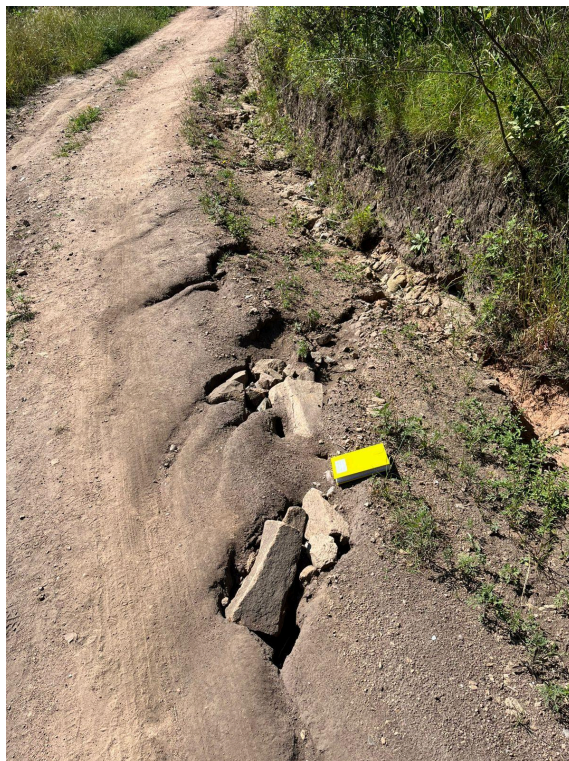
Figura 22- Ocorrência de sulcos e ravinas na estrada. Ponto 02.
