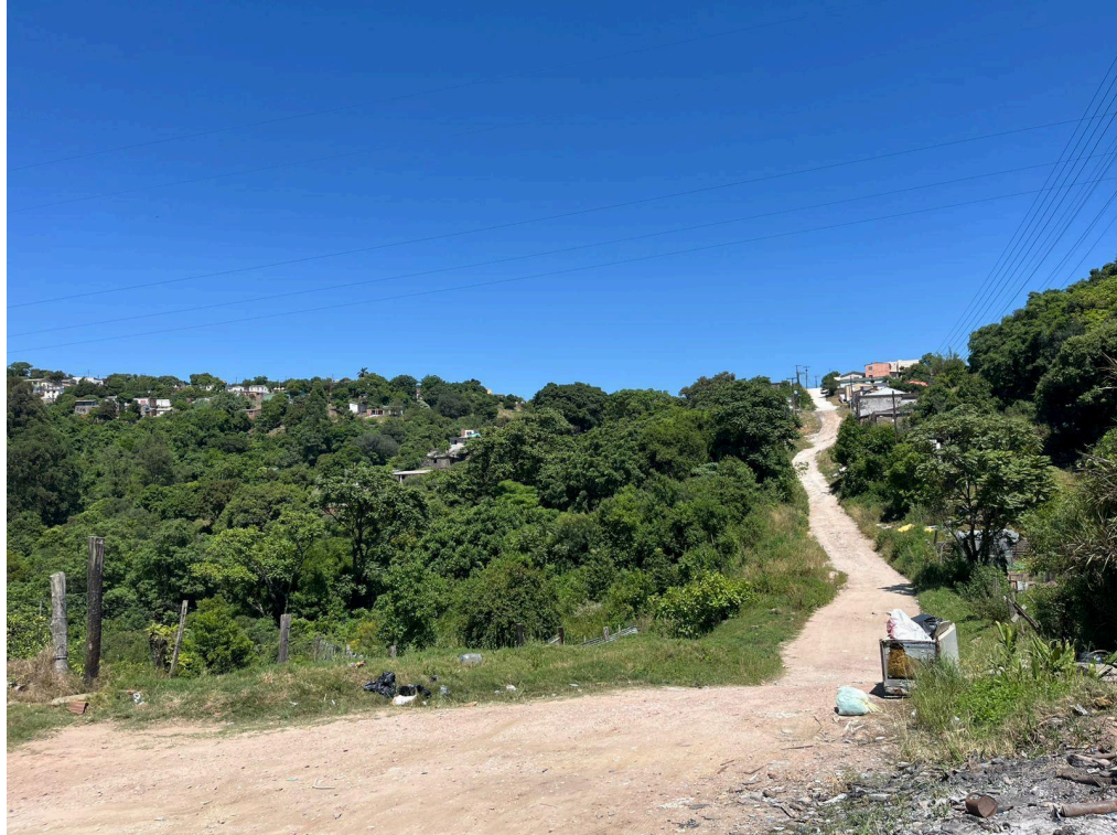
Figura 20- Registro fotográfico do ponto 07.
