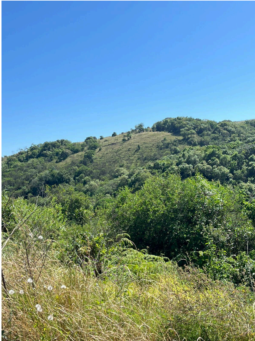
Figura 26- Perfil de curvatura convexo. Há ainda a presença de ranhuras no solo da encosta, o que pode indicar um movimento do tipo rastejo. Ponto 03.
