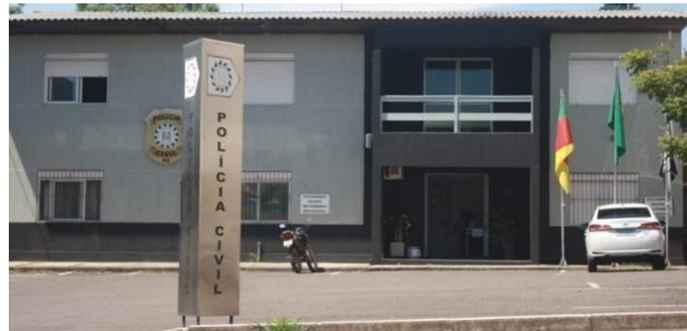
Figura 3 – Fachada da Delegacia de Polícia Civil de Estância Velha, referência para a maquete do Grupo 1.
