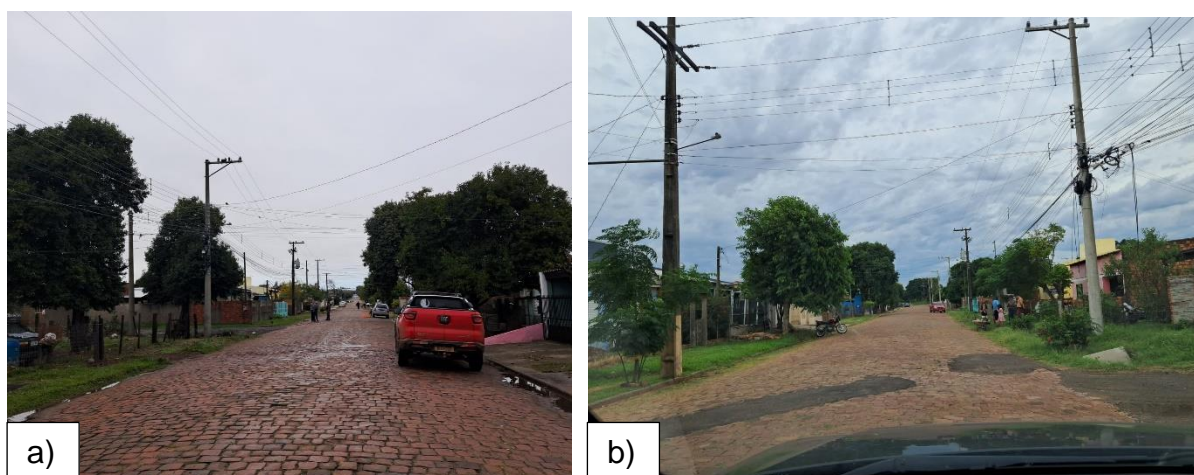
Figura 28 - Dispositivo de drenagem 'sarjeta' da bacia de contribuição
