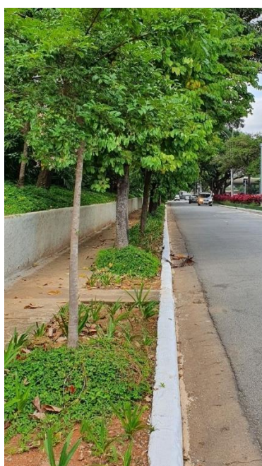
Figura 7 – Calçadas com poços de infiltração
