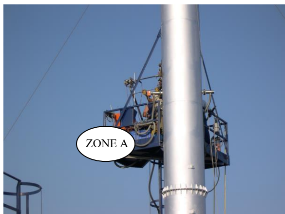
Figure 3 - 4 – Cheminée et plate-forme de prélèvements
