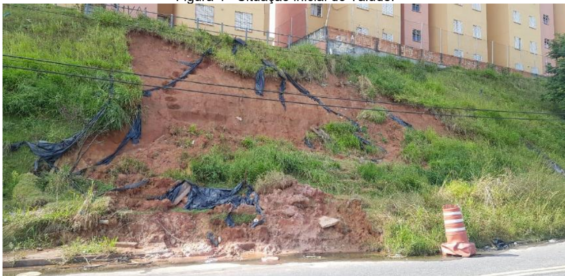
Figura 4 - Situação inicial do Talude.
