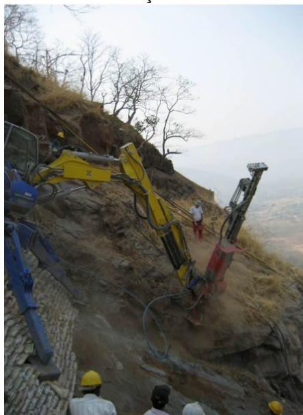
Figura 2 - Processo de introdução de estaca em talude.
