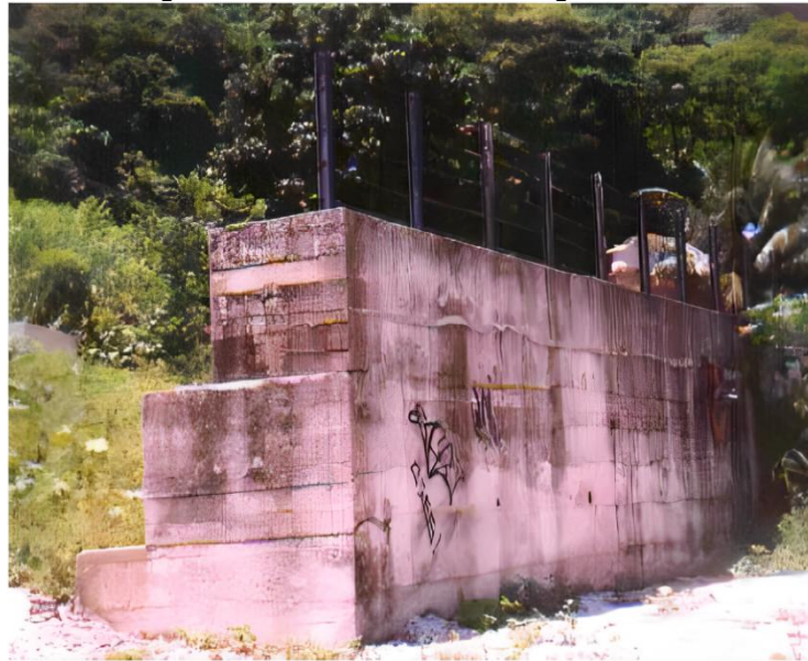
Figura 1 - Muro em concreto de gravidade.
