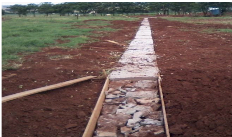
Figura 04. Construção do corredor de concreto
