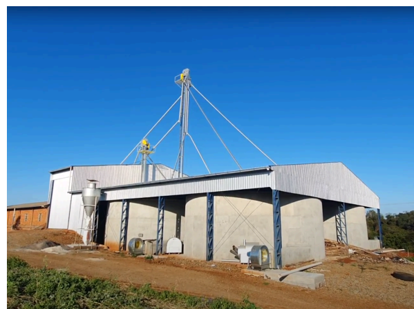
Figura 19. Parte externa do engenho do S Marcos Hentz.
