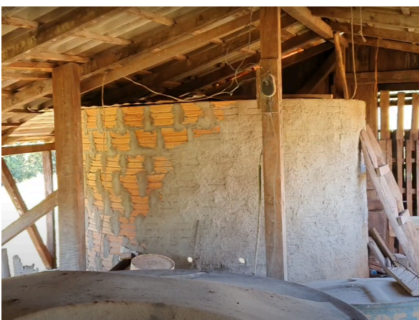
Figura 18. Parte externa do silo do Sr. Cremer.
