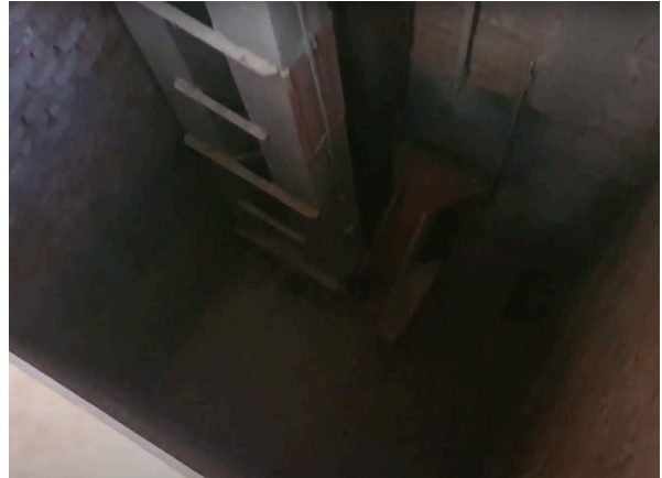
Figura 13. Base do elevador de grãos, onde a moega descarrega os grãos.
