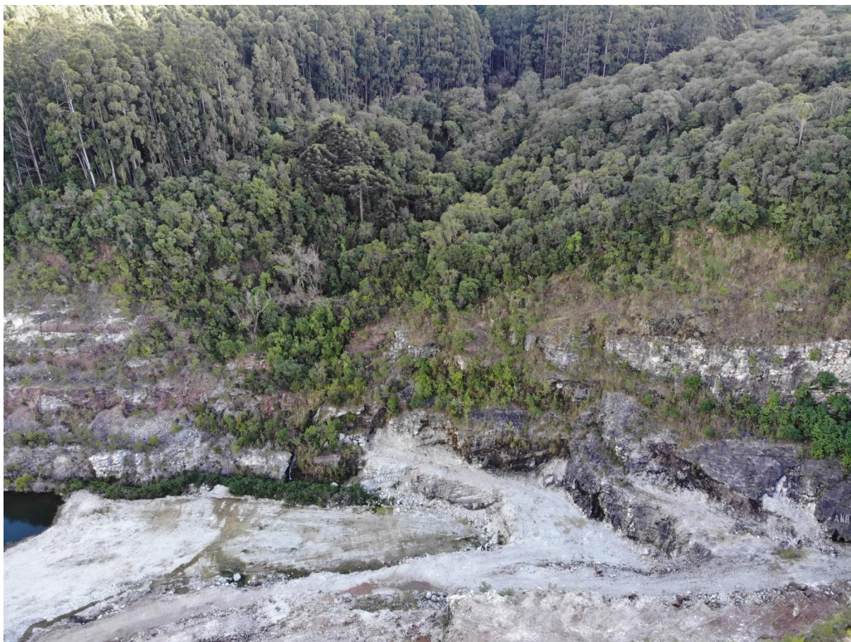
Figura 7 - Cava Sul com os taludes aparentes utilizados para descrição de litologias.
