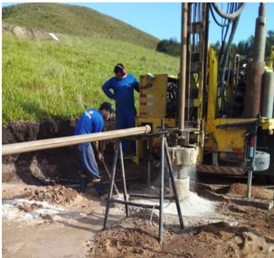
Figura 11 - Sondagem rotopneumática para fins exploratórios e prospectivos da jazida.
