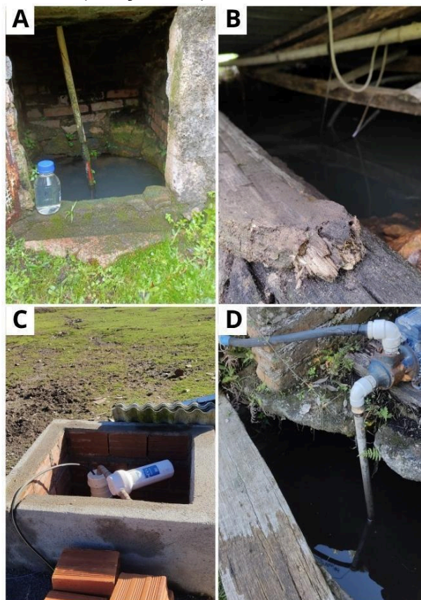
Figura 14 - Poços onde foram realizadas as coletas para análise hidrogeoquímicas: A) Cacimba A; B) Cacimba B; C) Poço C; D) Cacimba D.
