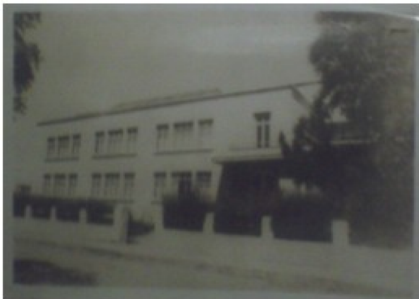
Figura 3: Prédio do Grupo Escolar Menna Barreto, 1918.
