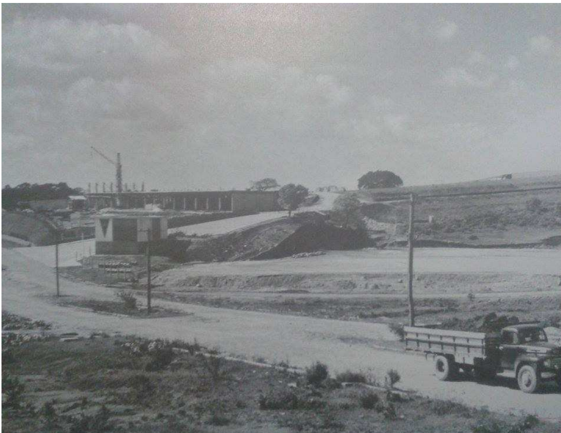
Figura 4 - Colégio Anchieta em construção no Bairro Três Figueiras (1957).
