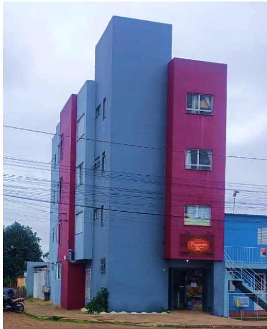
Figura 16 — Edificação estudada A - Alegrete (RS)
