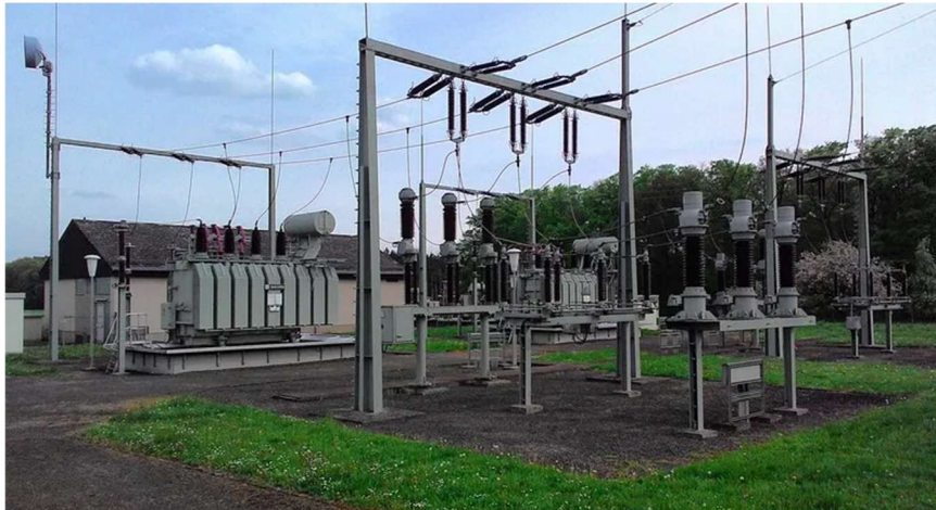
Figura 4 - Subestação Abaixadora
