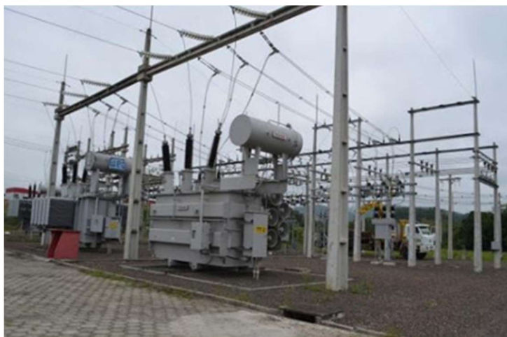
Figura 3 - Subestação Elevadora
