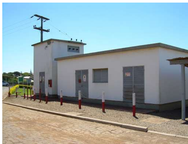
Figura 5 - Subestação Abrigada em Alvenaria
