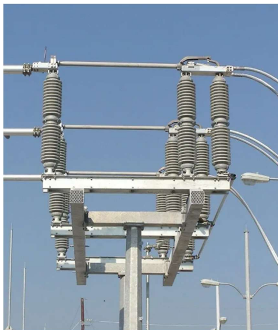
Figura 11 - Chaves Seccionadoras
