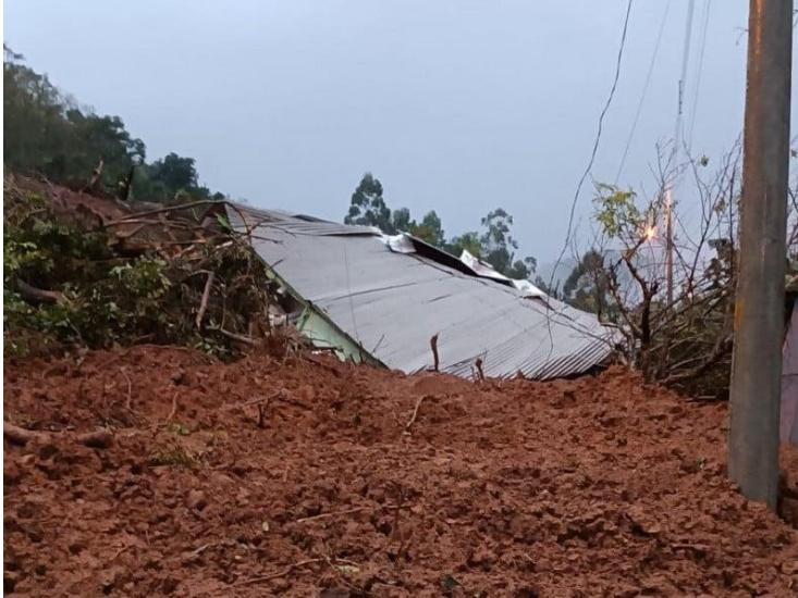
Figura 17 – Destruição parcial de residência em Roca Salles após inundação
