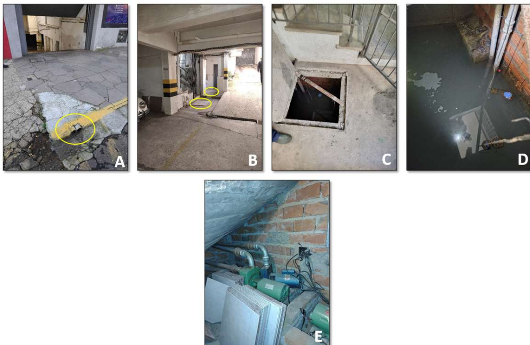
Figura 37 - Registro fotográfico da área 55, obtido no dia 23 de setembro de 2025. Ilustra: (A) frente da garagem subsolo, com destaque da tubulação na sarjeta; (B) garagem subsolo com destaque onde ficam as caixas/cisternas que armazenam as águas que vem dos drenos existentes embaixo do pavimento; (C) uma das cisterna aberta; (D) vista do interior da cisterna, com água e com canos das bombas submersas; (E) vista interna da casa de máquinas com dois motores para ligar a bomba submersa que existe na cisterna.
