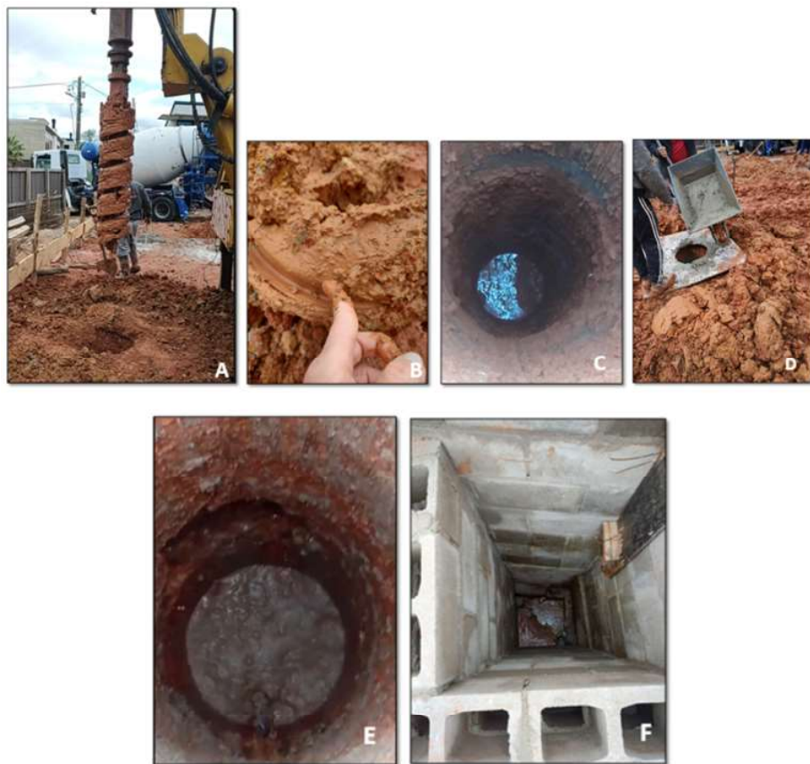
Figura 33 - Registro fotográfico da área 42, obtido no dia 08 de agosto de 2025. Ilustra: (A) perfuratriz rotativa retirando material argiloso e compacto; (B) detalhe do material retirado, consistência argilosa úmida; (C) furo vertendo água em 2,5 metros de profundidade logo após a perfuração; (D) concretagem do furo sendo feita; (E) água vertendo rapidamente e enchendo o furo; (F) caixa de inspeção do dreno feito em volta do terreno com profundidade de 2,5 m e com água.
