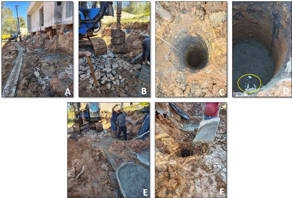
Figura 36 - Registro fotográfico da área 51, obtido no dia 29 de agosto de 2025. Ilustra: (A) residência que precisa de muro de contenção, com pilares expostos; (B) perfuração do solo sendo realizada; (C) furo de 4 metros pronto; (D) água começando a verter no fundo do furo; (E) colocação imediata da armação de ferro no furo antes de aumentar o nível da água (F) cimentação na sequência, antes do desmoronamento do furo.
