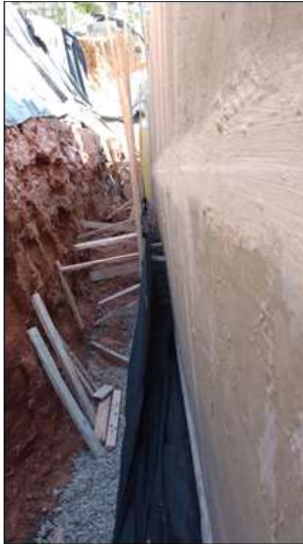
Figura 38 - Registro fotográfico da fase de instalação do dreno entre o terreno lindeiro e cortina de contenção da obra.
