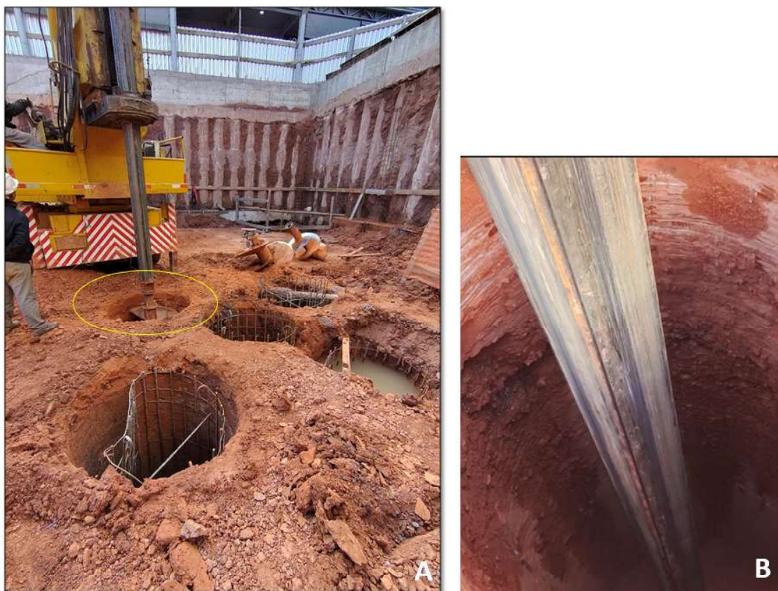
Figura 31 - Registro fotográfico da área 52, obtido no dia 29 de agosto de 2025. Ilustra: (A) perfuração para a instalação de pilares a partir da base da escavação dos 7 metros; e (B) detalhe da perfuração do argilito.
