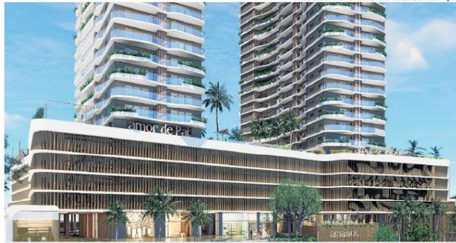
O Amaiivos terá torre de 34 andares (à esq.), em obras, e shopping no térreo. A 2ª torre teve projeto alterado e passará a ter 48 andares, podendo ser o mais alto do Estado. Construtora ainda não tem a nova arte gráfica
