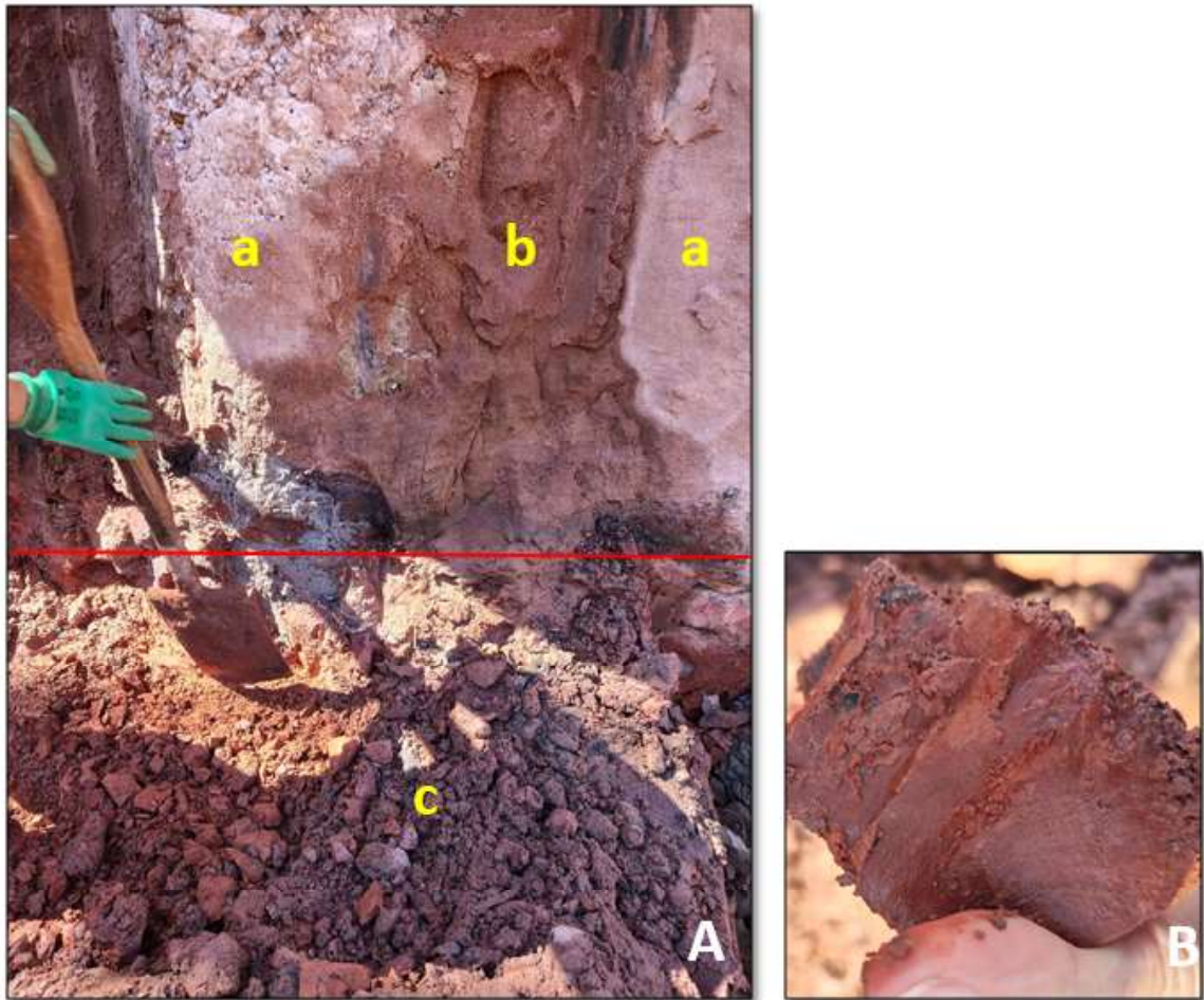
Figura 30 - Registro fotográfico da área 52, obtido no dia 29 de agosto de 2025, mostrando o contato entre o arenito com o argilito na primeira escavação dos 7 metros. (A) a linha vermelha identifica o contato da parede da escavação com a base da escavação; sendo “a” as estacas justapostas para contenção do arenito identificado em “b”; e “c” argilito na base. (B) detalhe do argilito.
