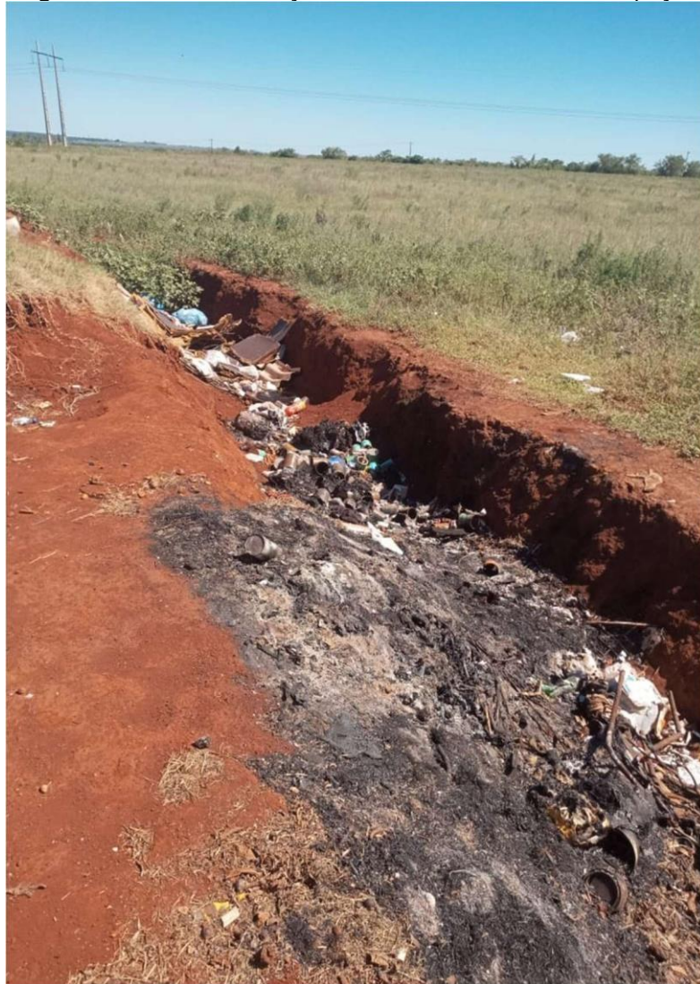
Figura 9 – valo de contenção divisor da lavoura com a ocupação
