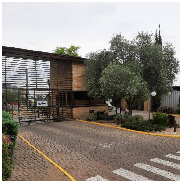
Foto 32 – Vista geral da saída do Condomínio B.
