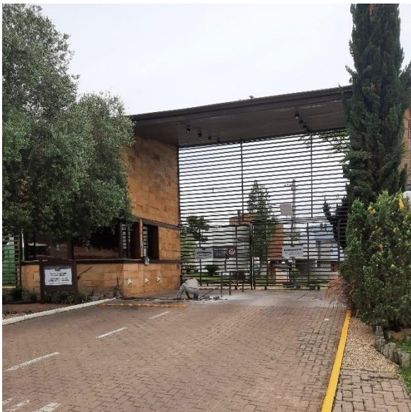
Foto 33 – Vista da portaria.
