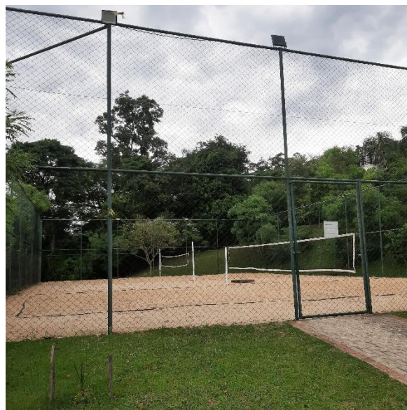
Foto 14 - Vista geral da quadra de areia.
