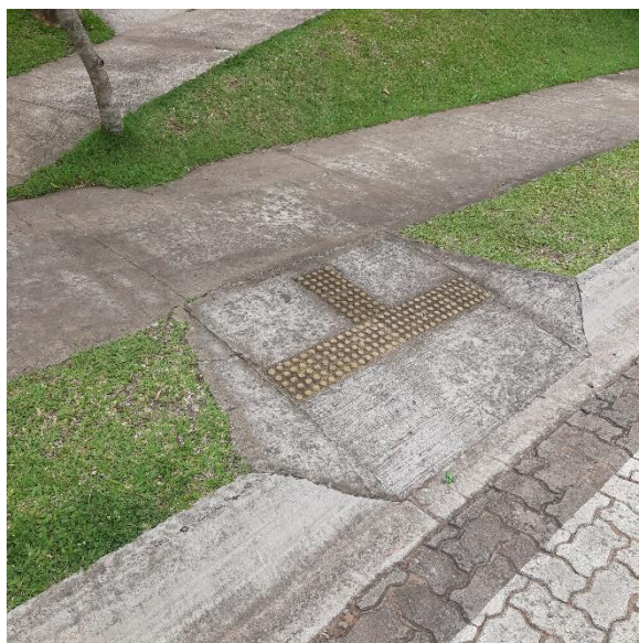
Foto 6 - Vista da rampa para cadeirantes: observa-se o piso tátil para deficientes visuais.
