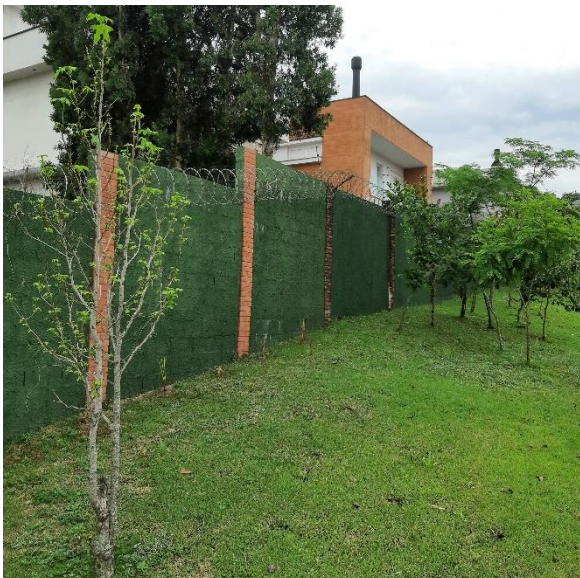
Foto 3 - Vista do muro externo do Condomínio horizontal A.
