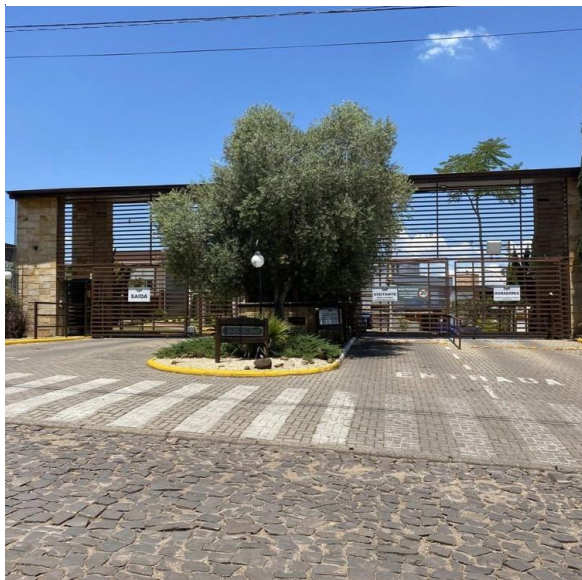
Foto 31 – Vista geral da entrada do Condomínio B.
