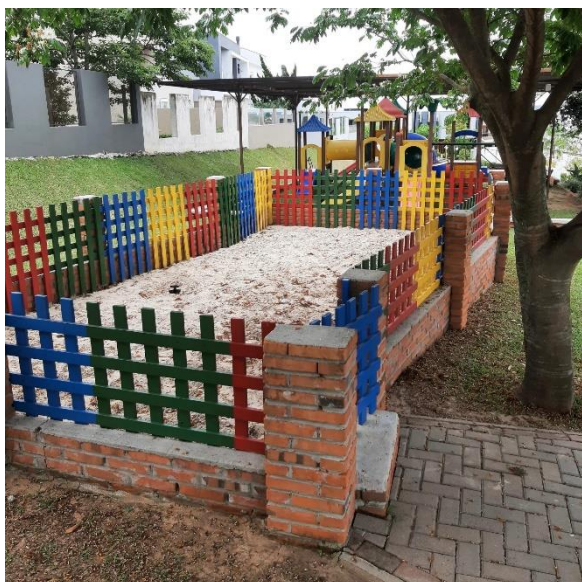
Foto 55 – Vista da caixa de areia do playground.
