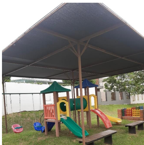
Foto 54 – Vista do playground: destaque para a estrutura de cobertura.
