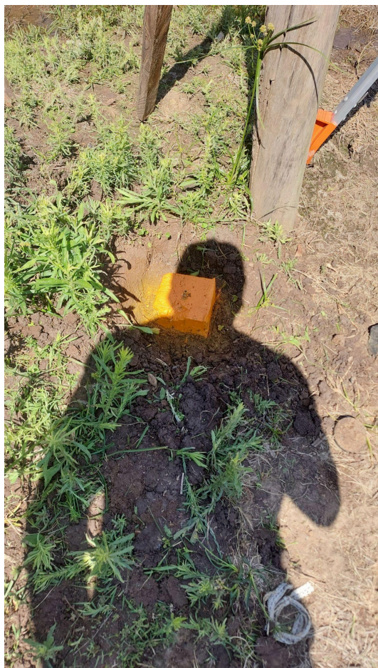
Figura 14: Repintura de destaque do marco, para melhor visualização conforme as normas
