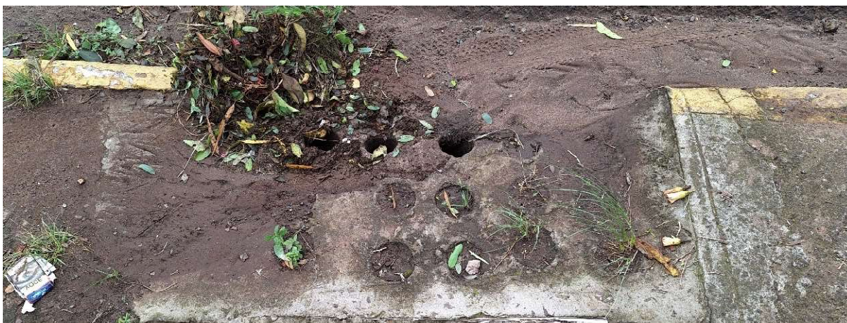
Figura 70 – Bueiro sobre rampa de travessia – Avenida Ibicuí
