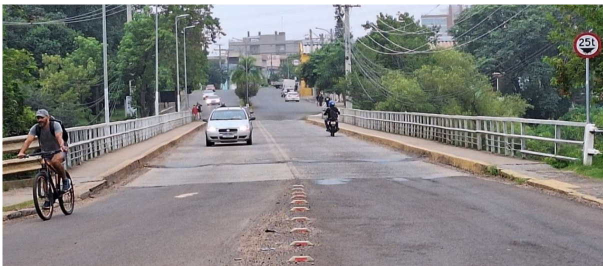
Figura 74 – Ponte Borges de Medeiros antes da reforma
