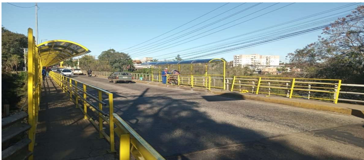
Figura 75 – Ponte Borges de Medeiros após reforma
