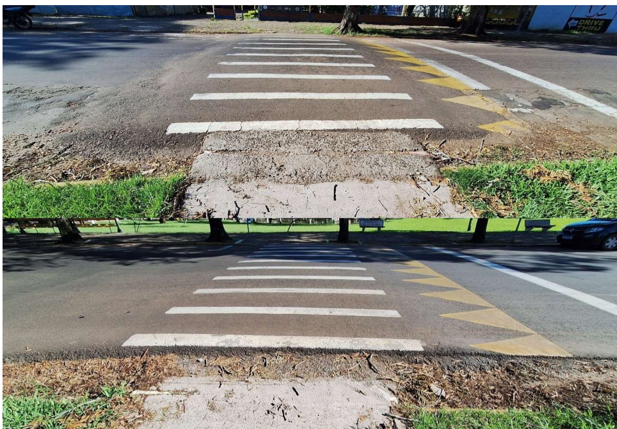
Figura 69 – Faixa elevada e rampas de travessia – Avenida Eurípedes Brasil Milano
