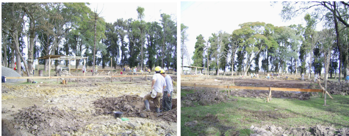
Figura 8 - Começo construção do Prédio I
