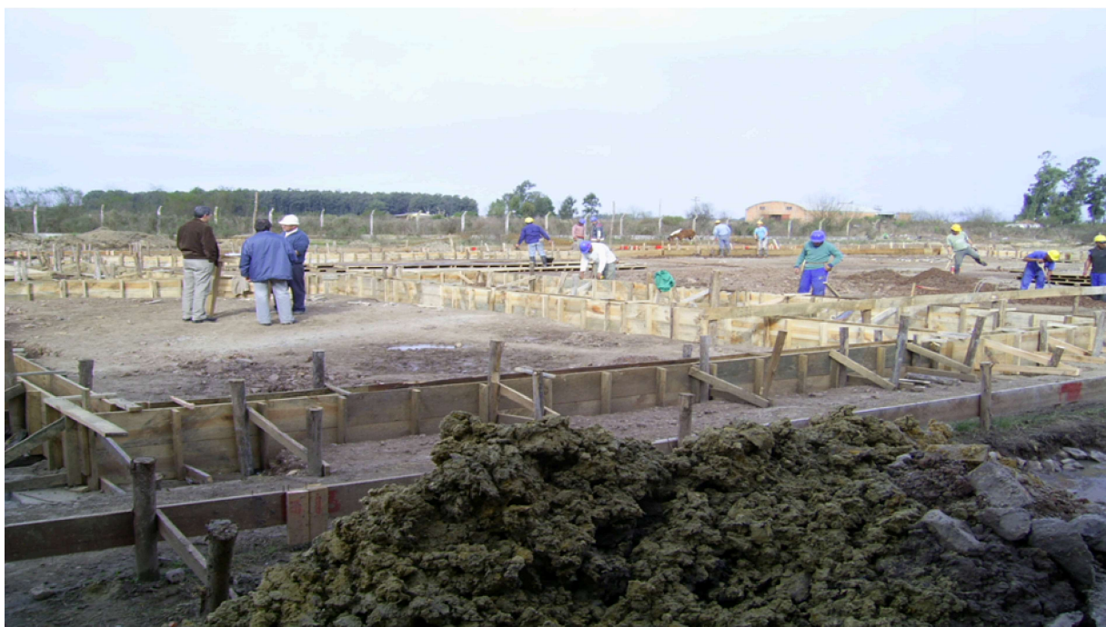
Figura 9 - Construção das estacas da fundação do Prédio I
