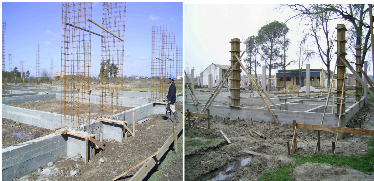
Figura 10 - Diferentes momentos da construção da Fundação do Prédio I
