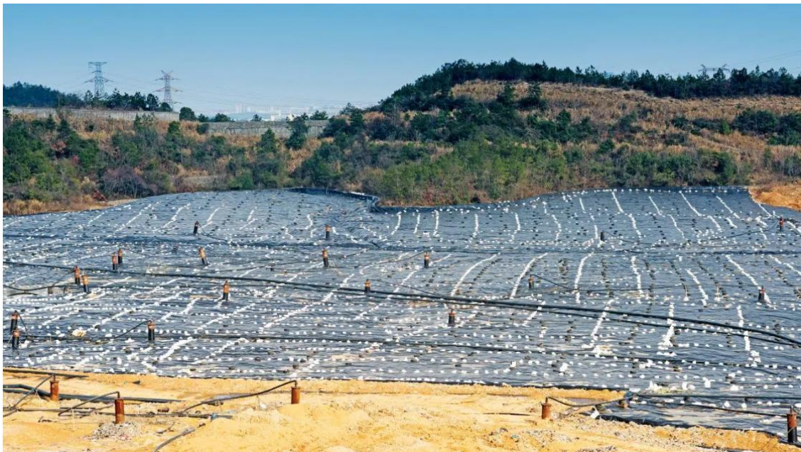
Figura 9 – Impermeabilização do aterro
