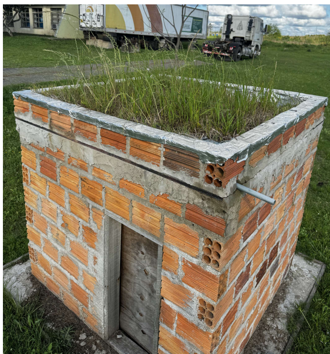
Figura 21 – Telhado Verde finalizado
