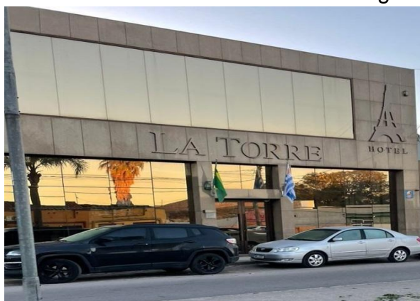
Figura 02: Fachada do Hotel La Torre de Jaguarão, RS
