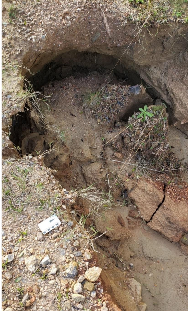
Figura 29 - Processo de erosão em ravina, evidências de fluxo hidráulico tipo "pipe".
