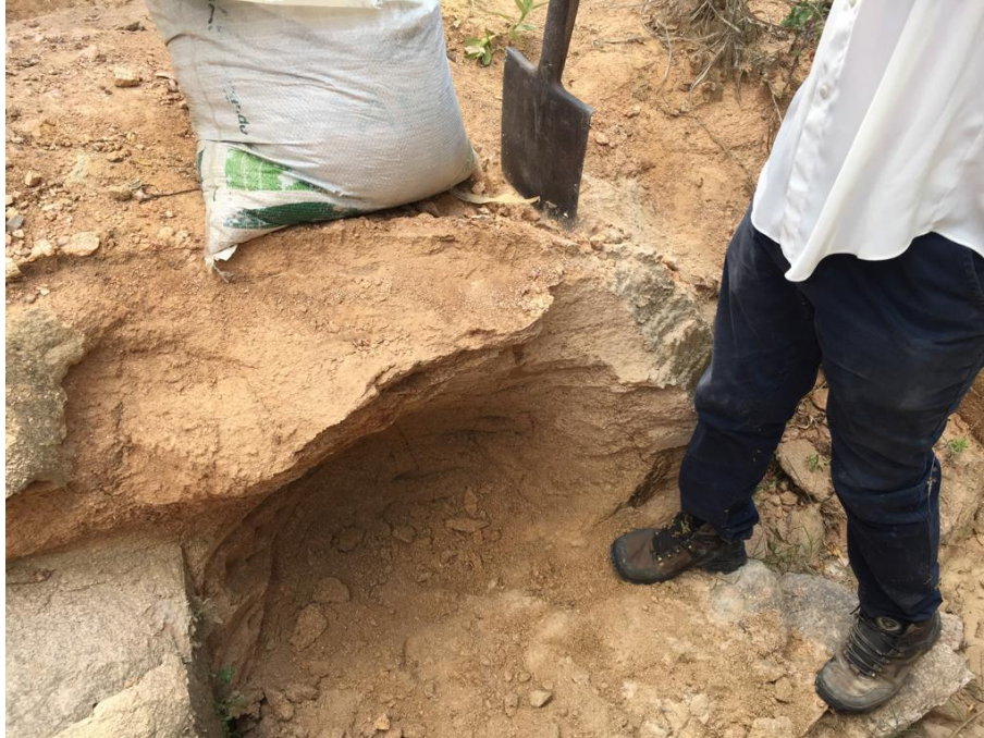
Figura 32 - Coleta de amostras de solo para ensaios Geotécnicos.
