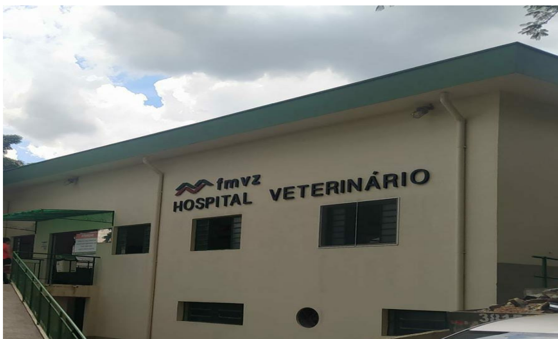
Figura 1 - Fotografia fachada do Hospital Veterinário – UNESP – Botucatu.
