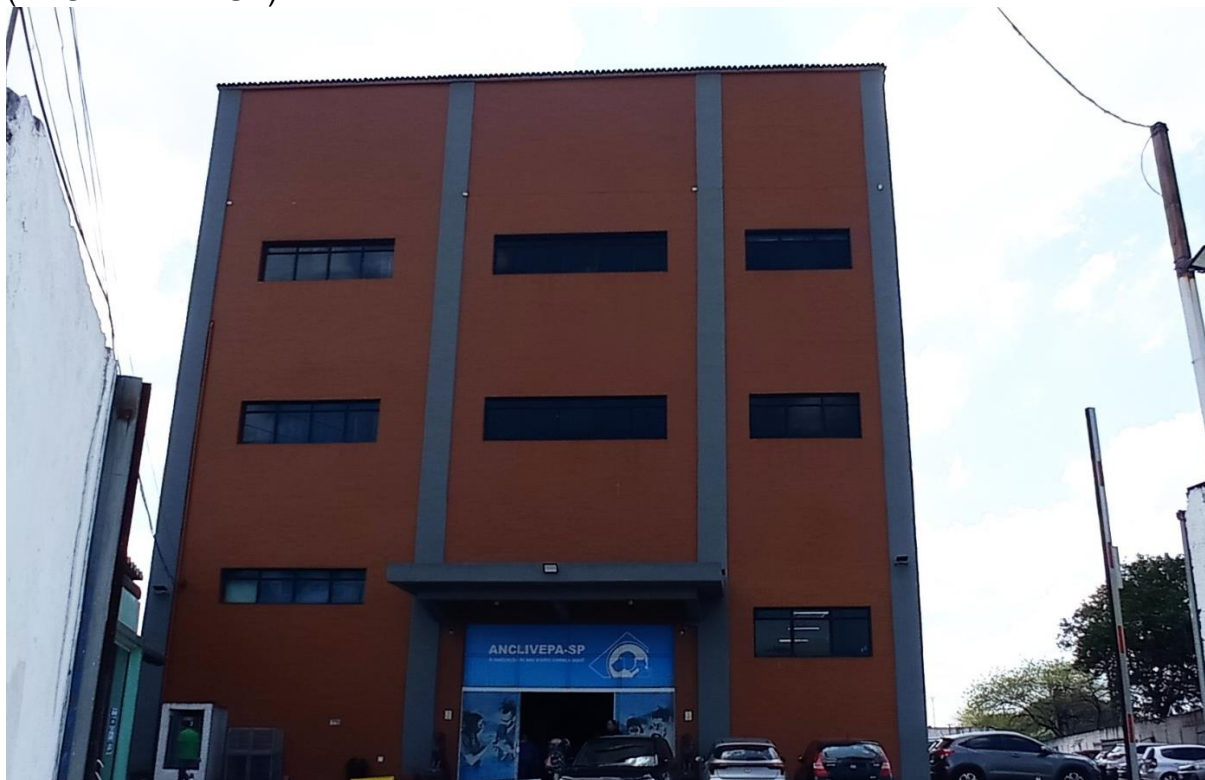
Figura 1 – Fachada externa do Hospital Público Veterinário – Unidade Zona Leste (ANCLIVEPA - SP).
