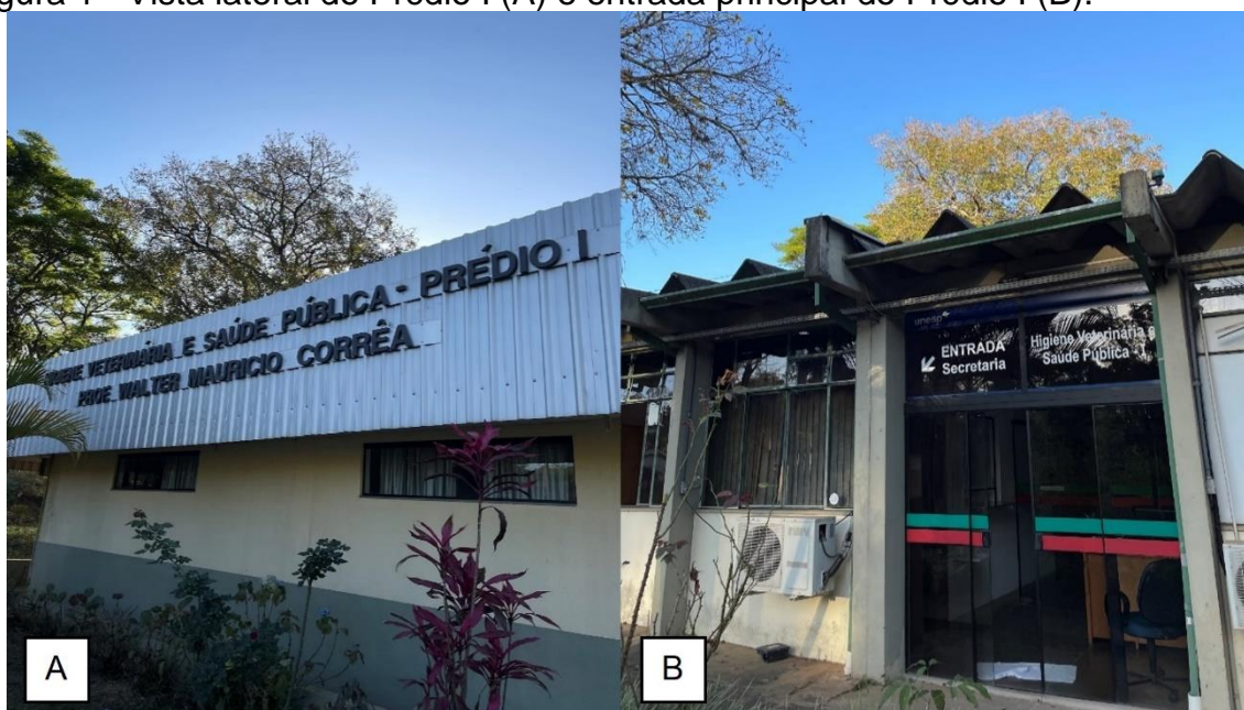
Figura 1 - Vista lateral do Prédio I (A) e entrada principal do Prédio I (B).
