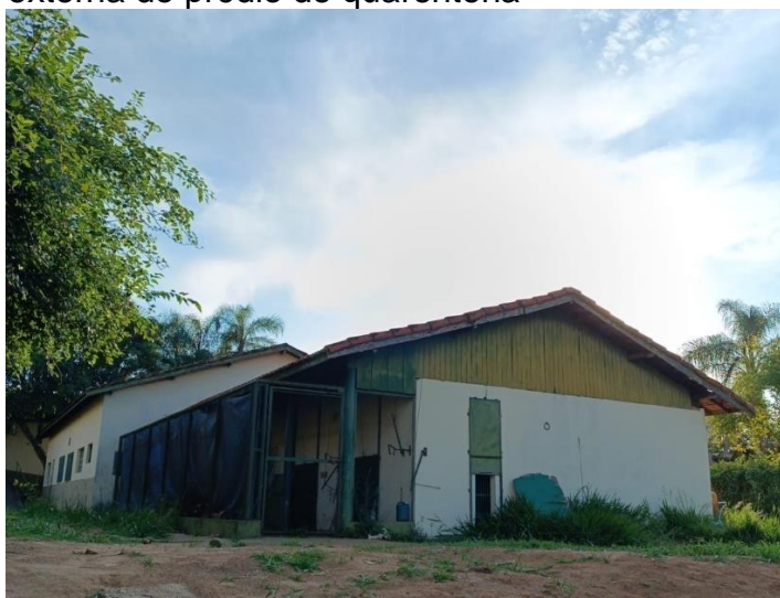
Figura 24 – Vista externa do prédio de quarentena
