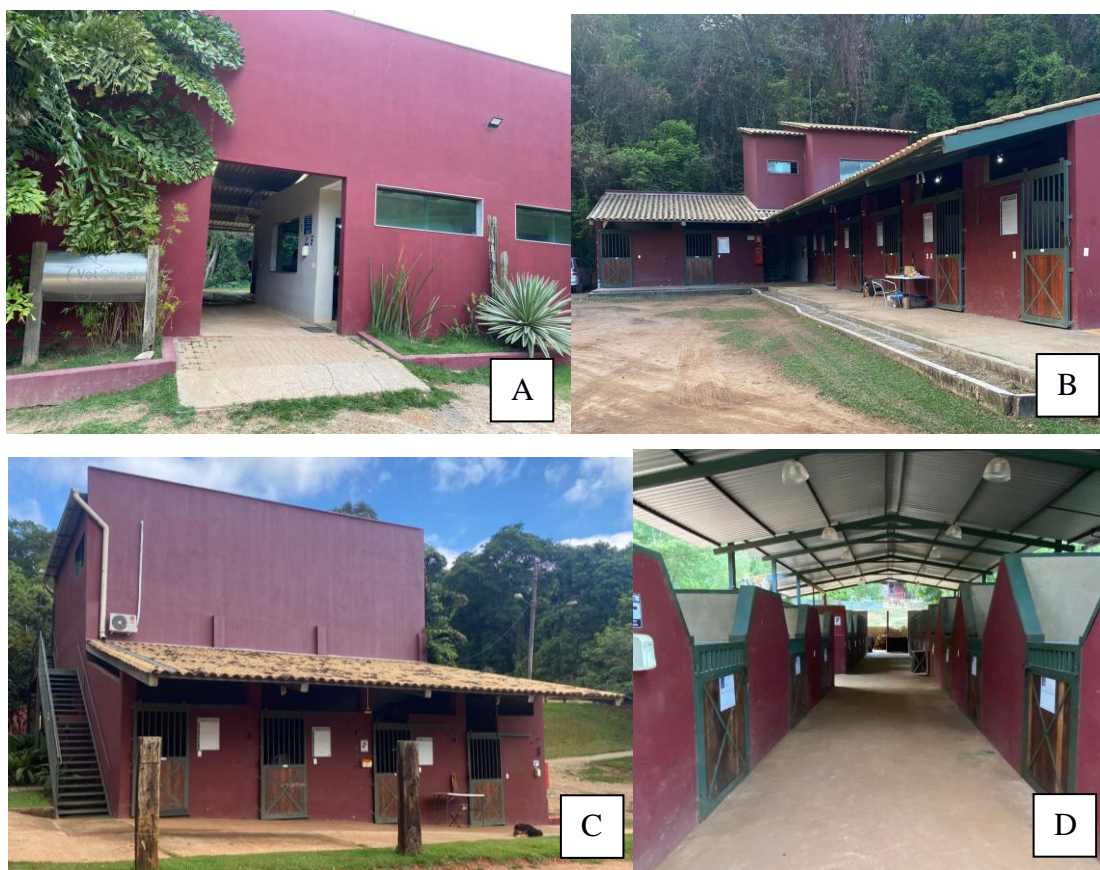
Figura 5 – Fachada do Hospital (A) Pavilhão 1 (B), pavilhão 2 (C) e pavilhão 3 (D) do Hospital Veterinário Vetcheck – Cirurgia Equina, Betim/MG.
