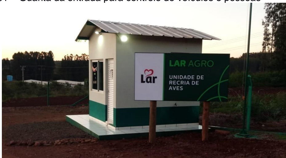
Figura 01 – Guarita da entrada para controle de veículos e pessoas
