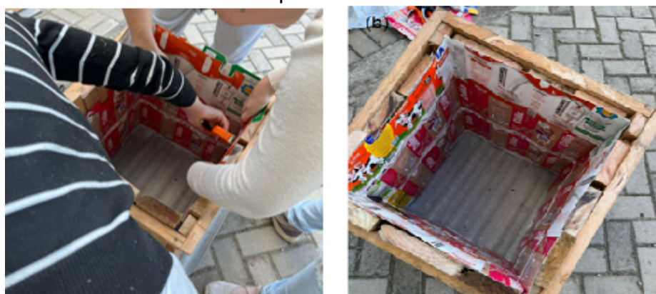
Figura 8 – Revestimento dos módulos de madeira: Protótipo revestido com o lado não laminado para dentro do ambiente.
