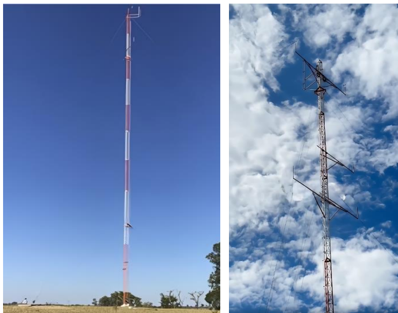
Figura 9: Torres de Medições Anemométrica (TMAs).
