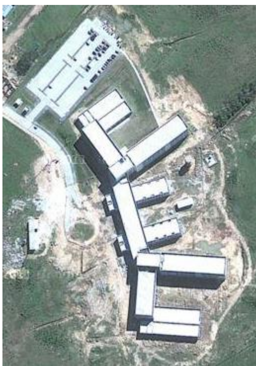
Figura 02: Instalações da UNIPAMPA Campus Bagé (RS).
