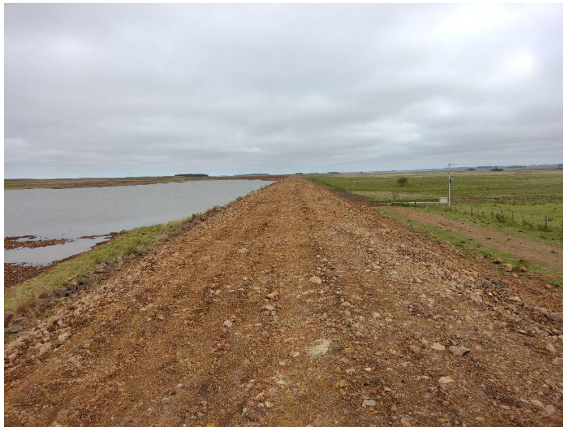
Figura 24 – Margem Esquerda da Barragem com posicionamento da rede elétrica em 23 kV
