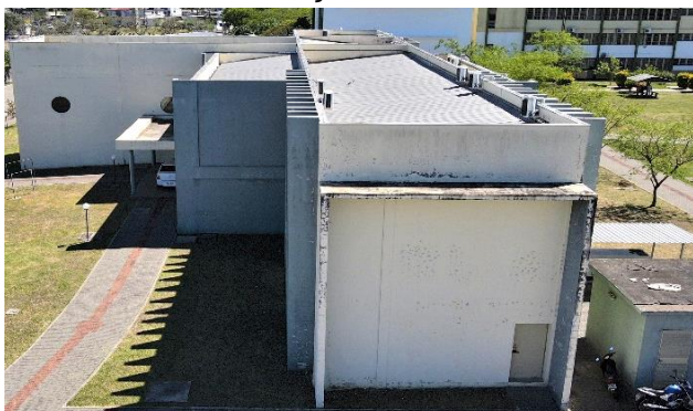
Figura 44 – Fachada sul antes da revitalização
