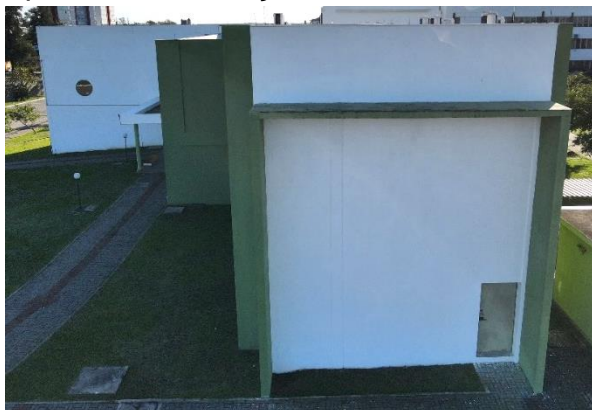
Figura 48 – Fachada sul após da revitalização
