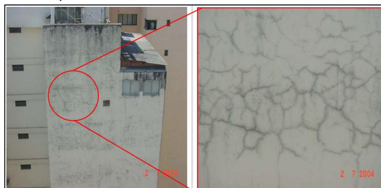
Figura 2 – Fissuras mapeadas
