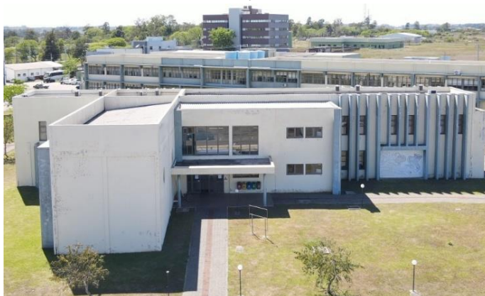
Figura 37 – Fachada oeste antes da revitalização
