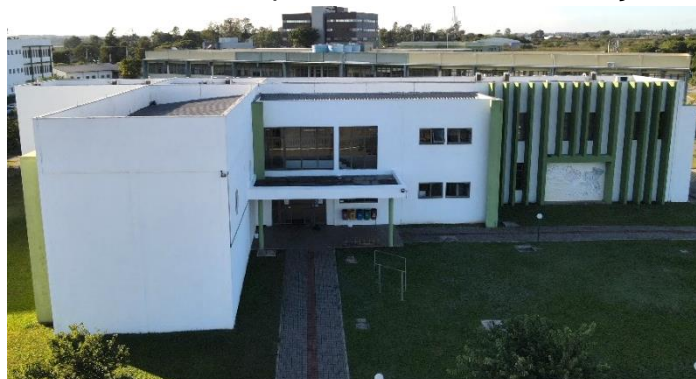
Figura 41 – Aspecto da fachada oeste após 6 meses a revitalização
