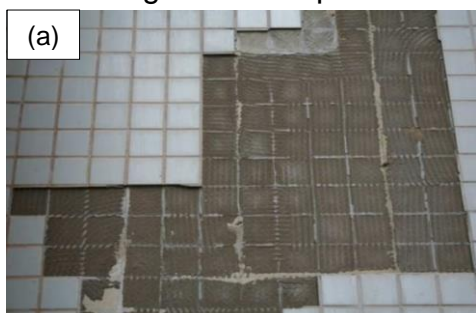
Figura 11 – Descolamento em placas: a) Perda parcial do revestimento cerâmico; b) Revestimento argamassado por falta de chapisco
