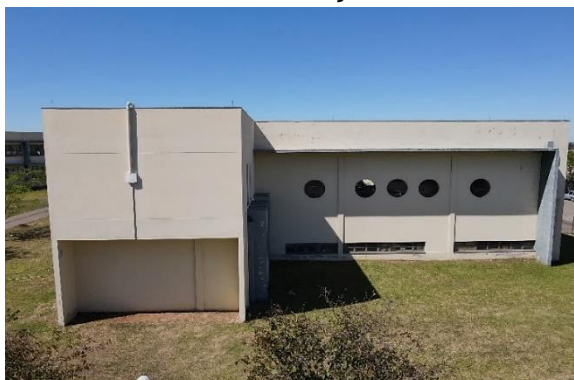
Figura 57 – Fachada norte antes da revitalização
