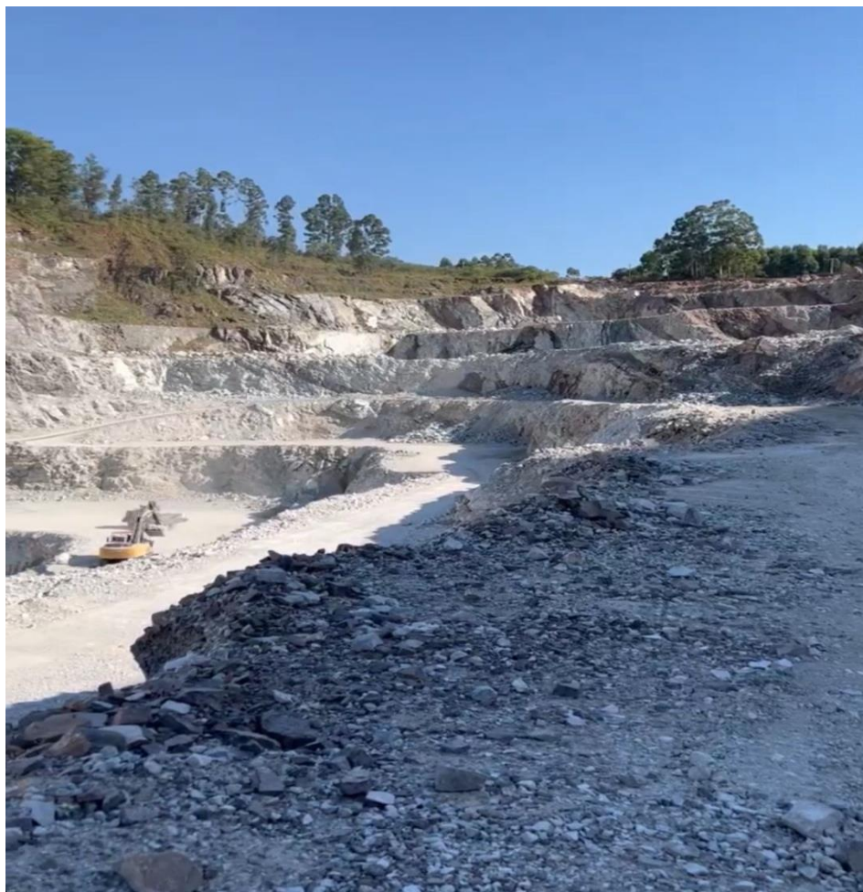
Figura 19 – Vista da lavra em cava da empresa Fida, onde é possível identificar as bancadas, essenciais para a otimização do trabalho
