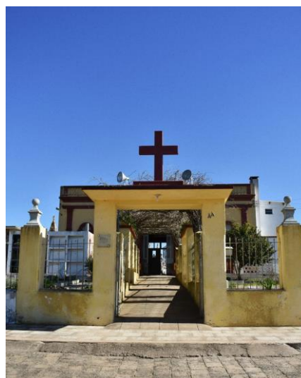
Figura 03: Fachada do cemitério atualmente. Fonte: Rafaeli Albrich Naressi (2021)
