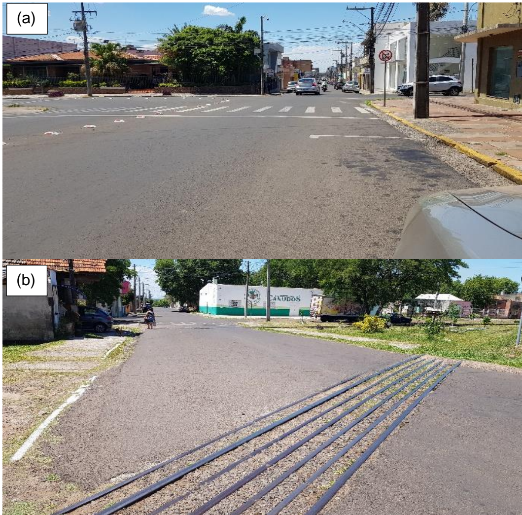
Figura 15 – Estado da R. dos Andradas (a) – Pavimento (b) – Cruzamento ferroviário.
