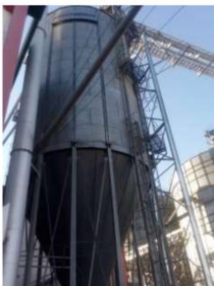
Figura 17 - Silo de armazenamento
