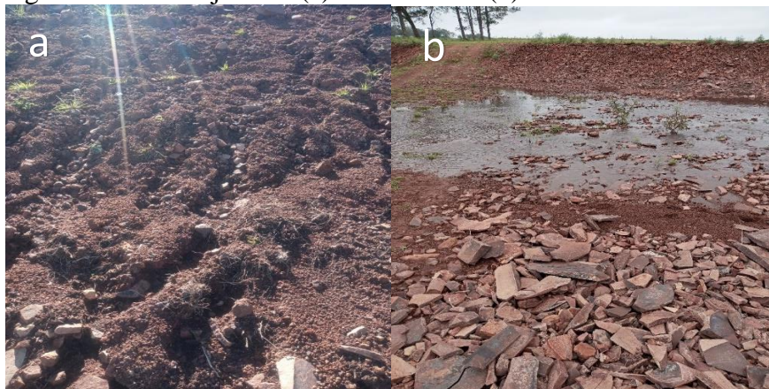
Figura 55 – Região do talude a jusante (a) e vertedouro (b).
