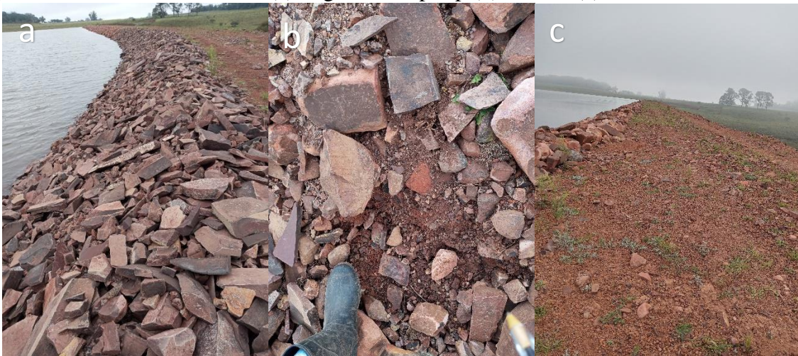
Figura 56 – Talude de montante (a), regiões do rip-rap (b) e crista (c).
