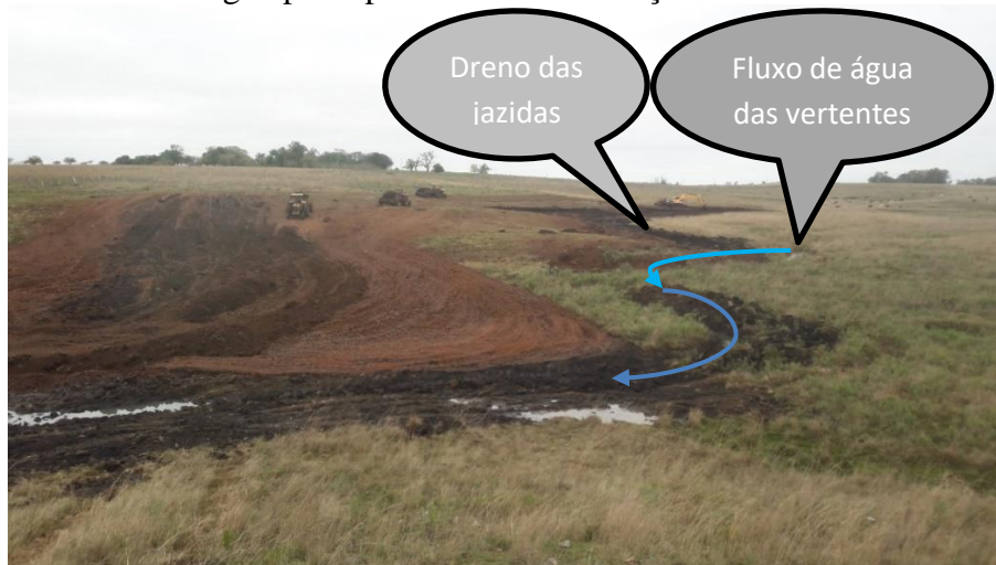
Figura 28 – Dreno do talvegue principal e área de inundação.
