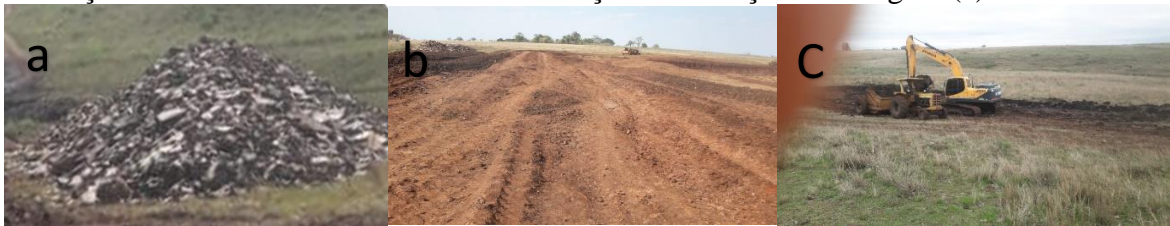
Figura 26 – Material escavado na fundação (a), disposição das camadas no maciço (b) e observações dos materiais utilizados na construção do maciço da barragem (c).
