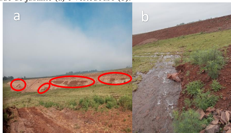
Figura 58 – Talude de jusante (a) e vertedouro (b).
