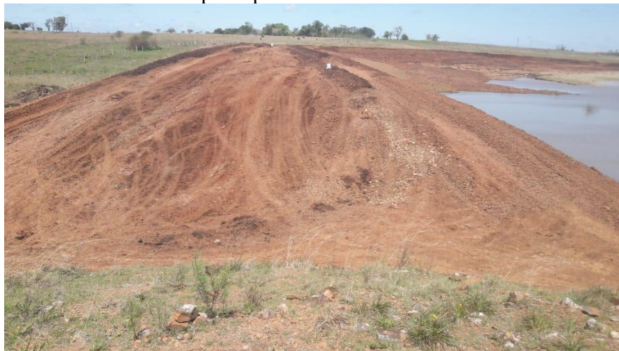
Figura 29 – Fechamento do dreno principal.
