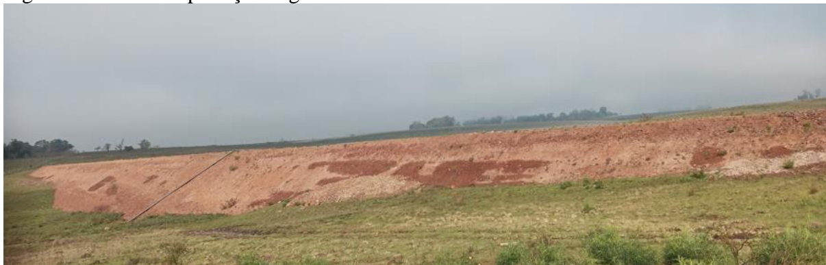
Figura 63 - Falha na proteção vegetal.
