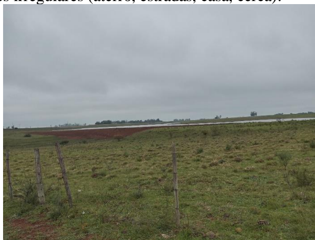
Figura 68 - Construções irregulares (aterro, estradas, casa, cerca).
