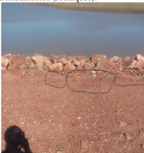
Figura 60 - Desabamentos/afundamentos (recalques).
