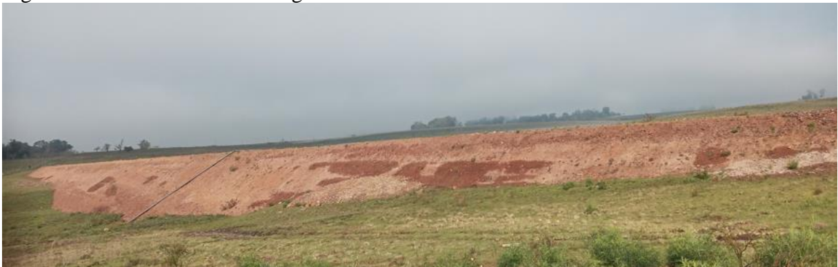
Figura 33 – Barramento da barragem.
