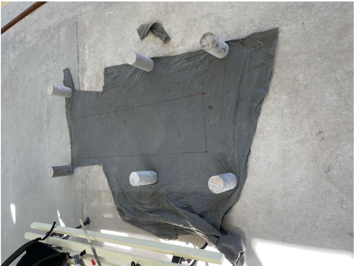
Figura 21: Corte realizado no geotêxtil não tecido.
