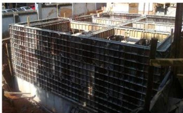
(b) cisterna construída em cimento armado
