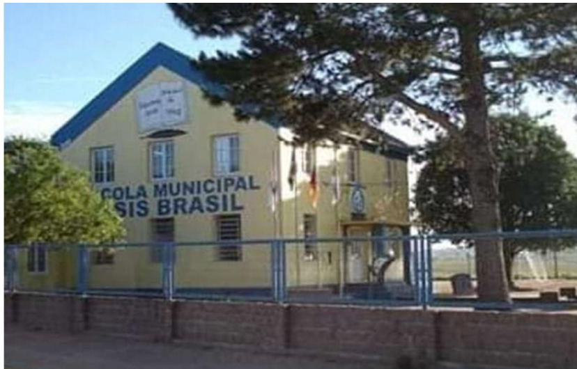
Figura 4 – Prédio principal da Escola Municipal de Ensino Fundamental Assis Brasil
