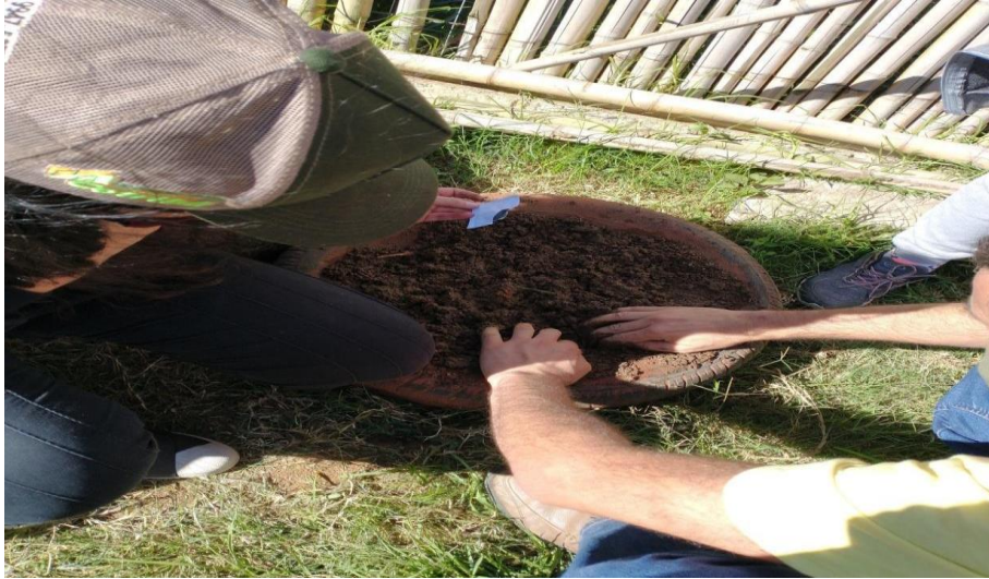
Figura 23 – Pneus sendo preenchidos com terra
