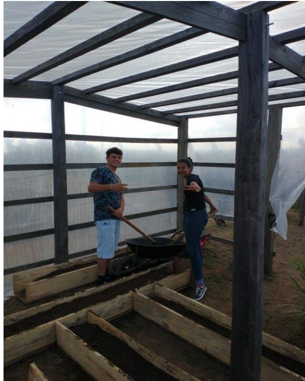
Figura 19 – Canteiros sendo preenchidos com terra
