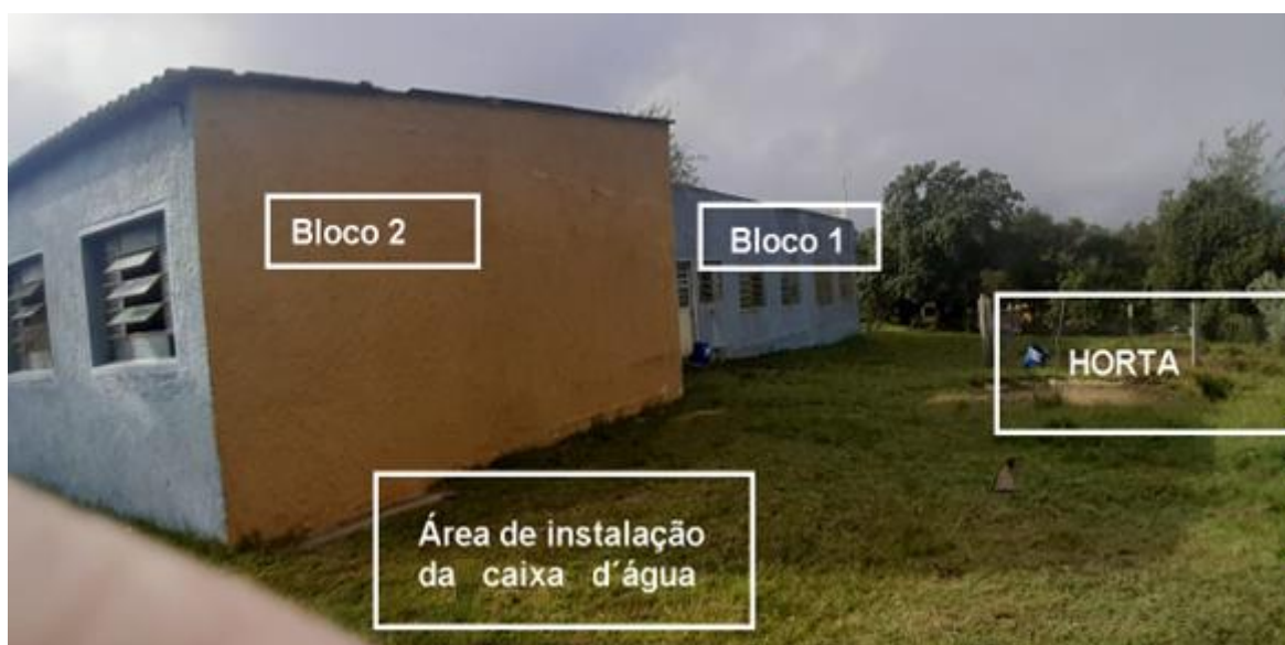
Figura 10 – Local de instalação das caixas d'água
