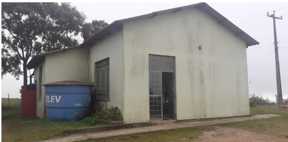
Figura 7 – Caixa d'água utilizada para armazenar água potável
