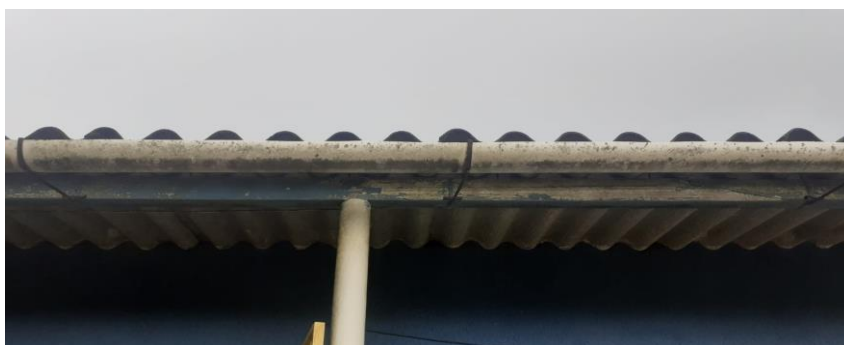
Figura 9 – Calhas instaladas no telhado do Bloco 1
