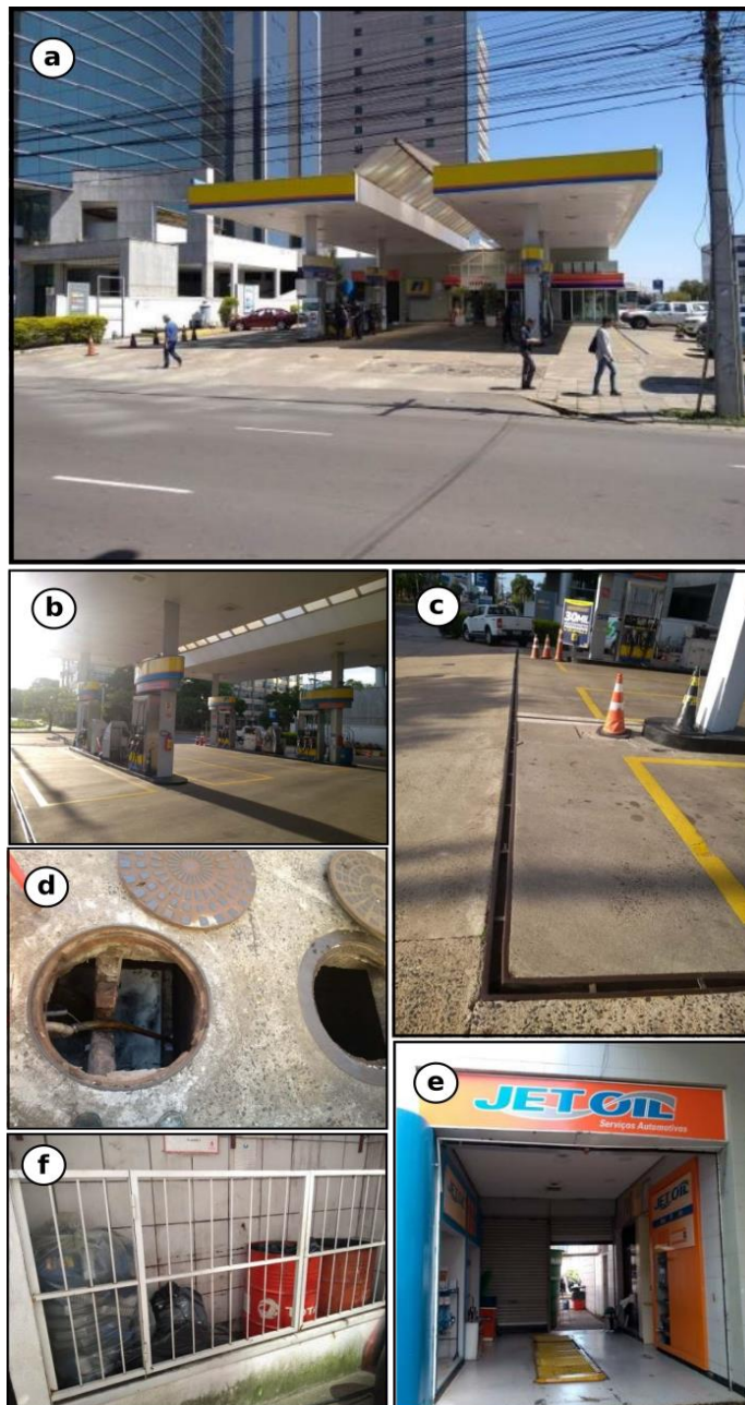
Figura 17 – a) Vista geral do posto revendedor; b) piso impermeável da área do abastecimento; c) piso envolto por canaletas de metal; d) caixa separadora de água e óleo; e) vista da área de troca de óleo; f) local utilizado para o armazenamento dos resíduos Classe I.
