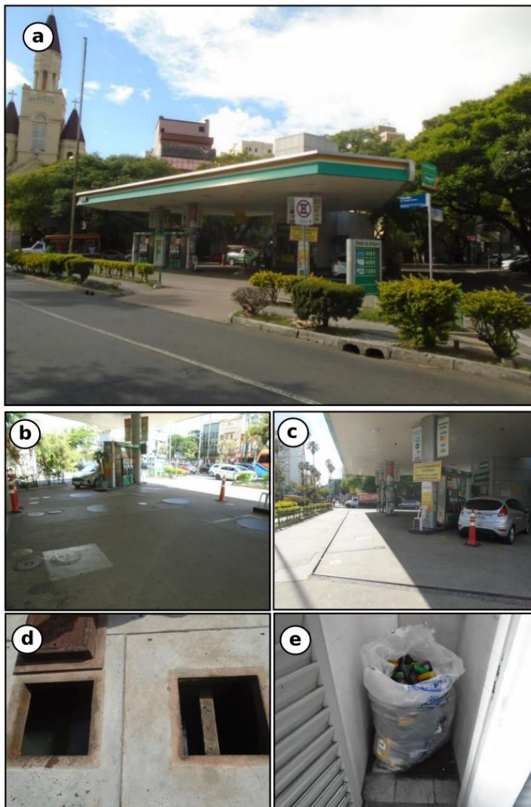
Figura 16 – a) Vista geral do posto revendedor; b) piso impermeável da área de tancagem subterrânea; c) piso envolto por canaletas de metal; d) caixa separadora de água e óleo; e) local utilizado para o armazenamento dos resíduos Classe I.
