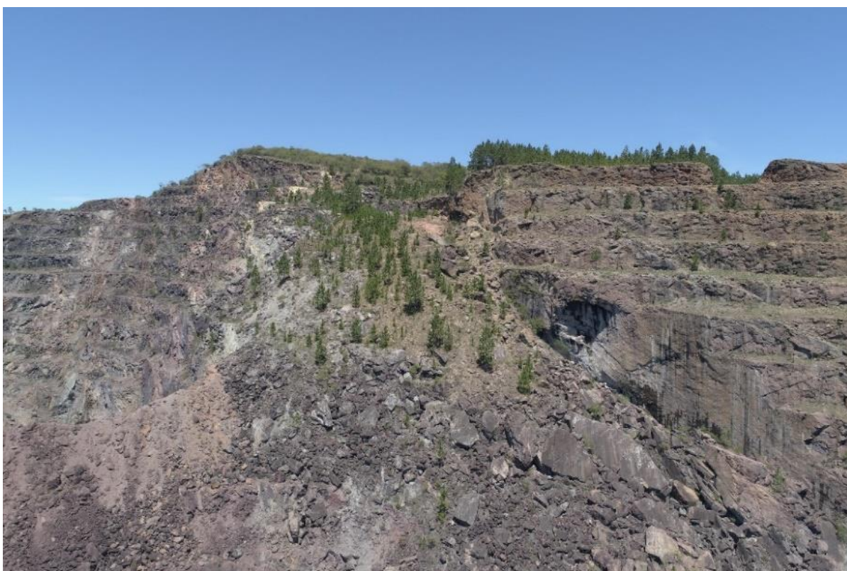
Figura 18 - Zona da ruptura, hoje naturalmente revegetada.
