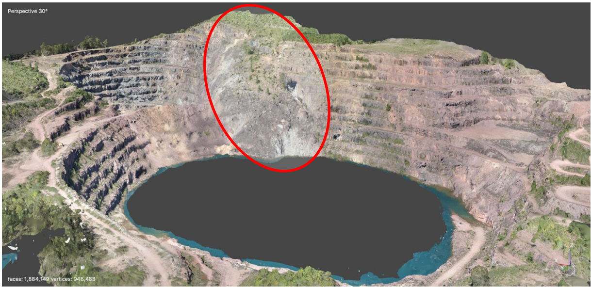
Figura 2 - Local da ruptura global de taludes, na porção sul da cava da Mina Uruguai.
