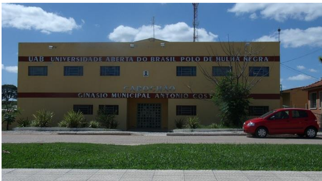
Figura 3- Fachada do Polo UAB - Hulha Negra
