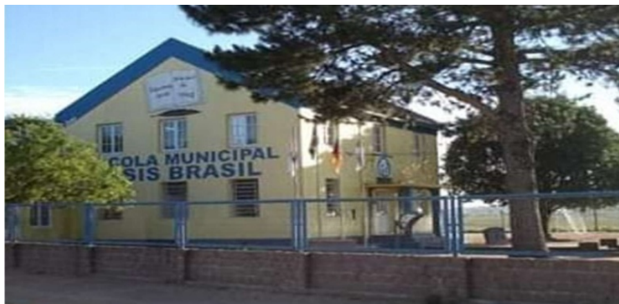
Figura 1 – Prédio da Escola Municipal de Ensino Fundamental Assis Brasil
