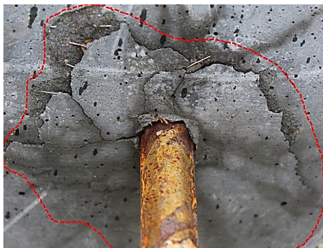
Figura 72. Panorama de fissuração por aderência na extremidade de uma amostra do grupo C2.V.20.
