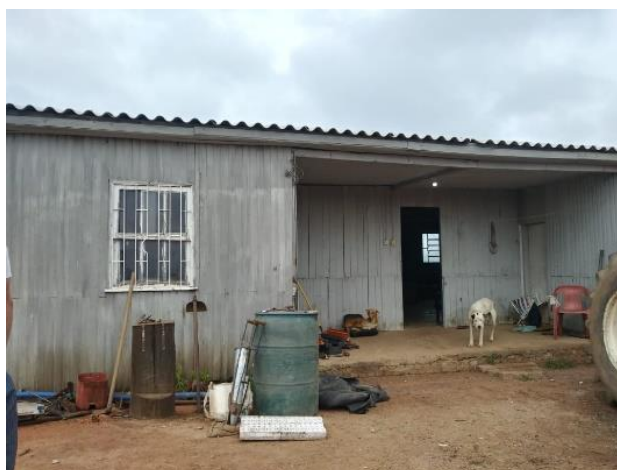
Figura 10 – Imagem da fachada da Residência do local
