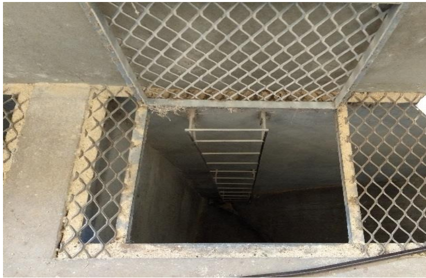
Figura 9 - Moega para recebimento de grãos e sementes. UBS Instituto Federal Farroupilha.
