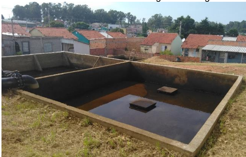
Figura 18 – Reservatório de armazenamento da água da lavagem de filtros
