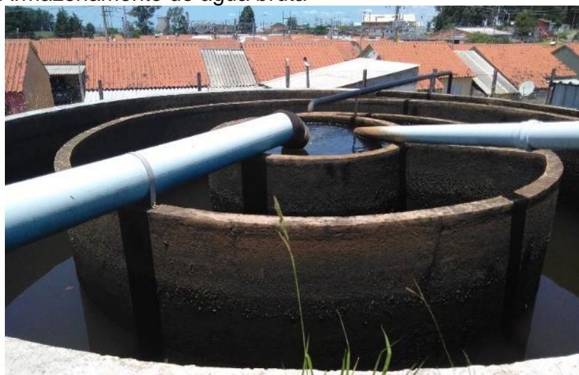
Figura 11 – Armazenamento de água bruta
