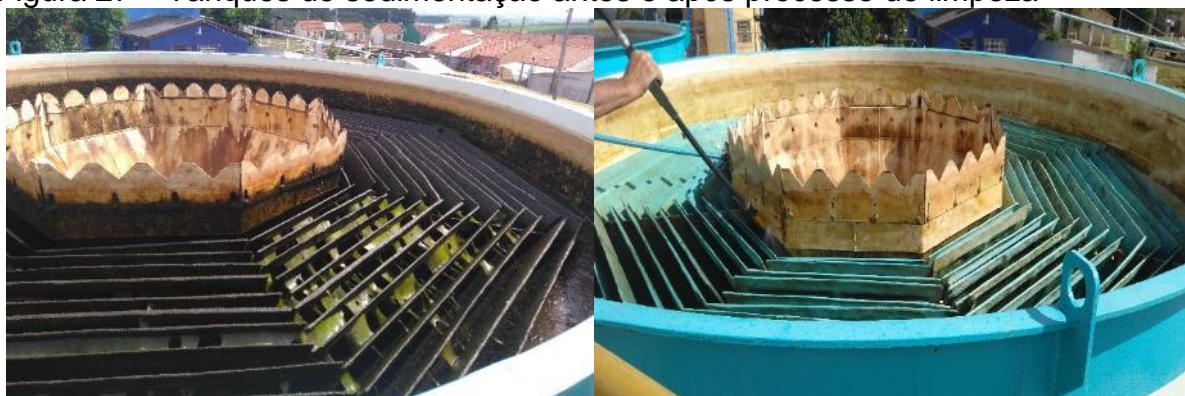
Figura 27 – Tanques de sedimentação antes e após processo de limpeza
