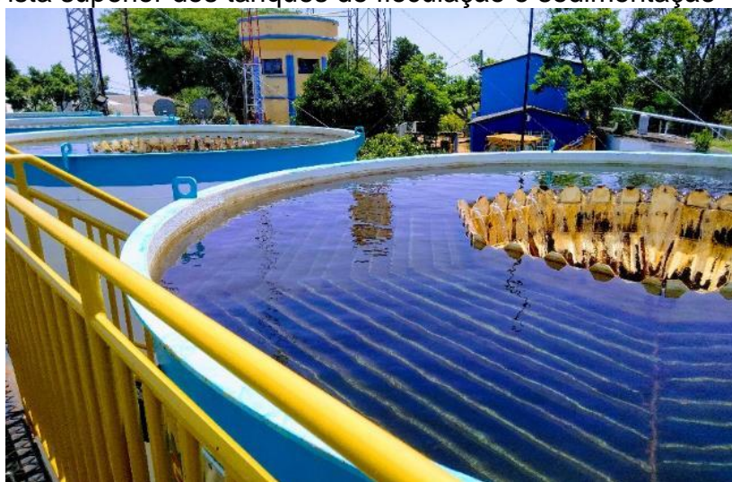
Figura 13 – Vista superior dos tanques de floculação e sedimentação
