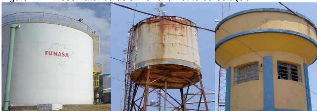
Figura 17 – Reservatórios de armazenamento da estação
